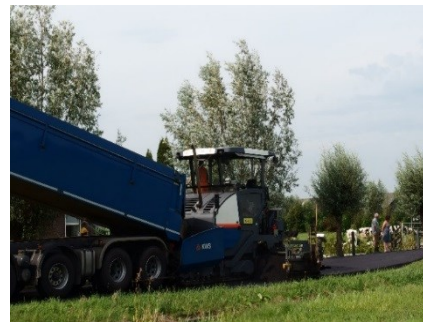
100 % gerecycled asfalt in Ouderkerk aan de IJssel
