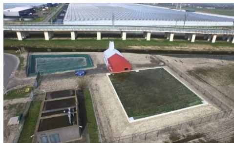
Testlocatie van een lokale waterzuivering van AquaReUse
