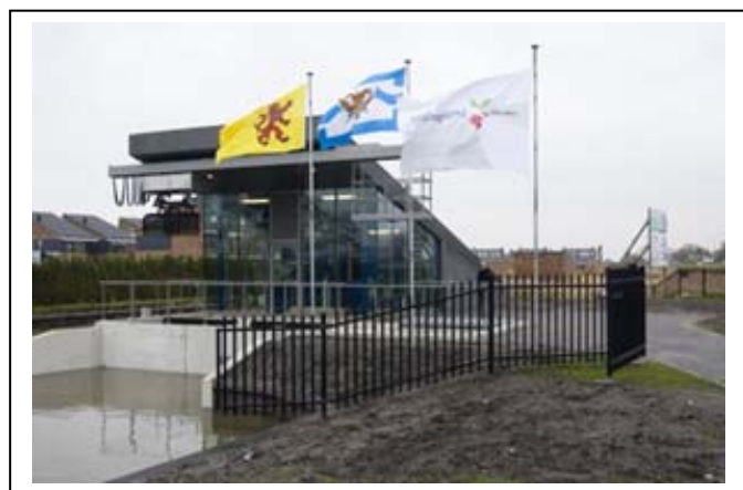
Gemaal Meerpolder, de grootste uitvoering in de nieuwe huisstijl van gemalen van Delfland.
